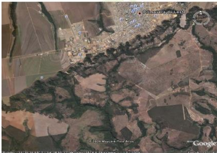
Figura 30. Escarpa erosiva da Chapada dos Guimarães nas proximidades do município de Primavera do Leste, limite norte da bacia.
