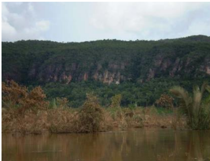
Figura 137. Escarpamento na margem esquerda do lago próximo ao barramento
